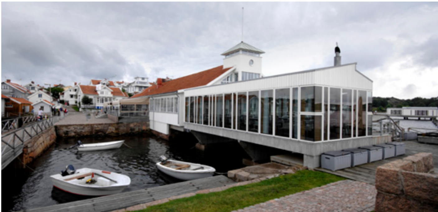
Gullmarsstrands integrerade bergvärmesystem utnyttjar så väl värmen som kylan från borrhålen för att få rätt temperatur på anläggningen.
