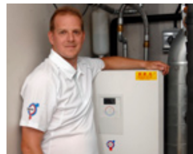
Magnus Bergquist visar den värmepump som Berghogens Rör installerat.
